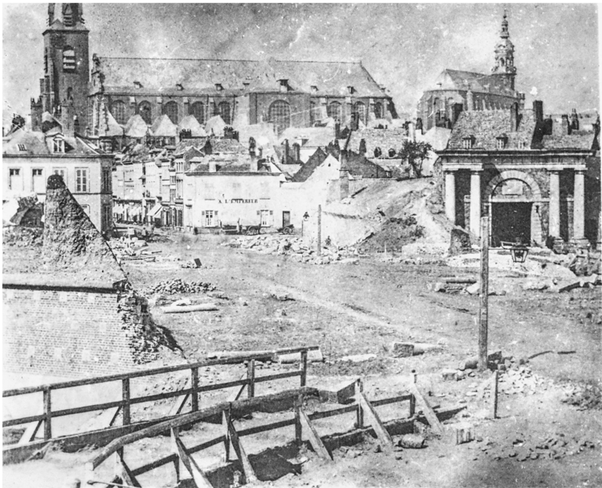
Destruction de la porte d'Havré vers 1864
