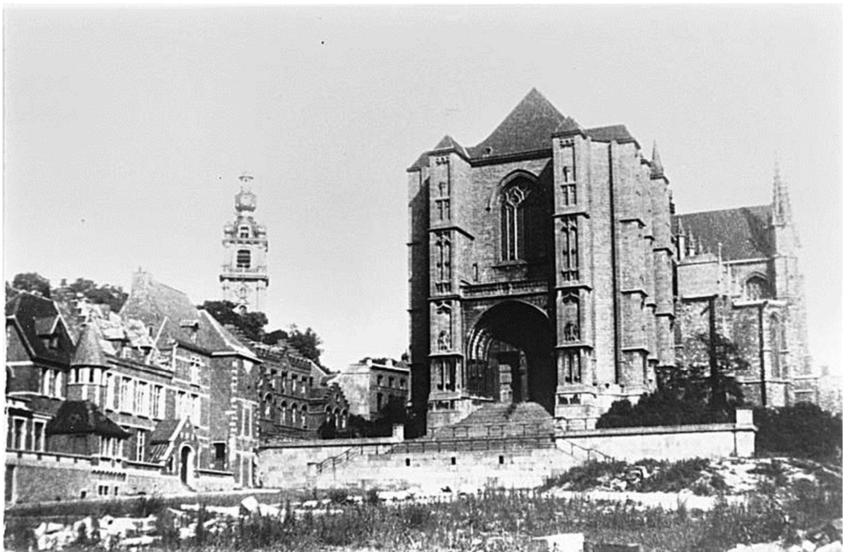
Le square en chantier (fin des années 40)
